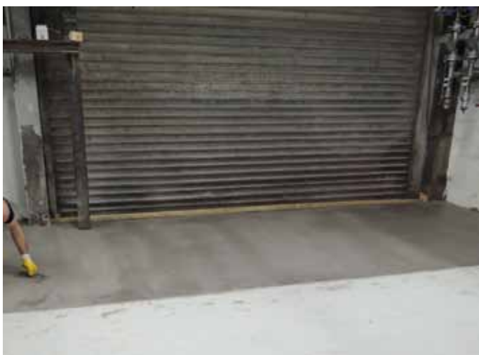
Vyrovnaní nerovností podkladu, druhý krok
