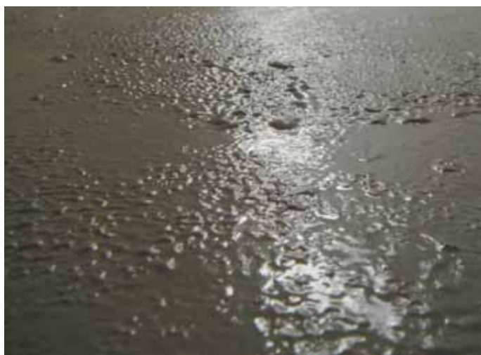
Tvorba puchýřů při vztlínající vlhkosti
