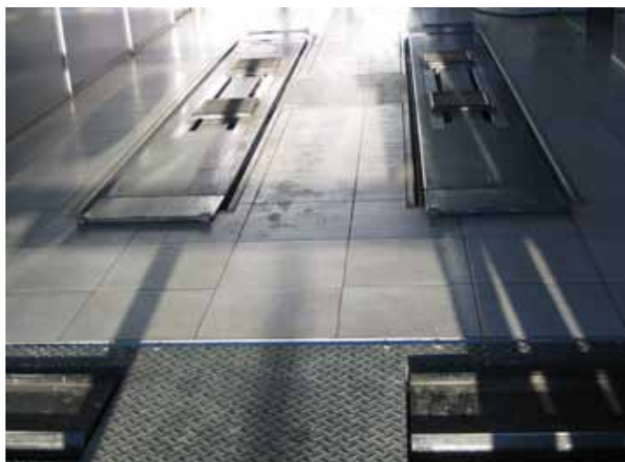
Použití dlažeb v exponovaném prostředí autodílny
